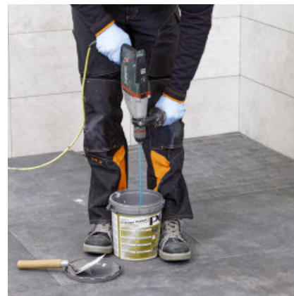
Goed mengen. Om een homogeen mengsel te krijgen, moet het mengsel in een andere emmer worden gedaan en nogmaals gemengd.
