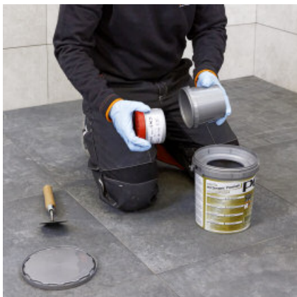
Emmer PCI Durapox Premium (2 kg) openen en de tweede component eruit halen.
