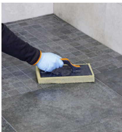
Dan met een sponsbord de restsluier verwijderen en het oppervlak wassen.
