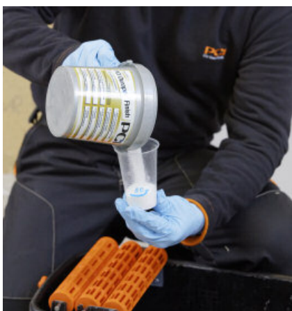
Een andere optie is PCI Durapox Finish (geconcentreerd) 1 : 100 aan het waswater toe te voegen (50 ltr. water : 50 g Durapox Finish).
